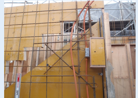
2階壁配筋②
