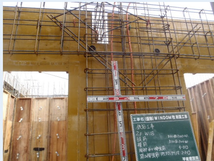
2階壁配筋①
